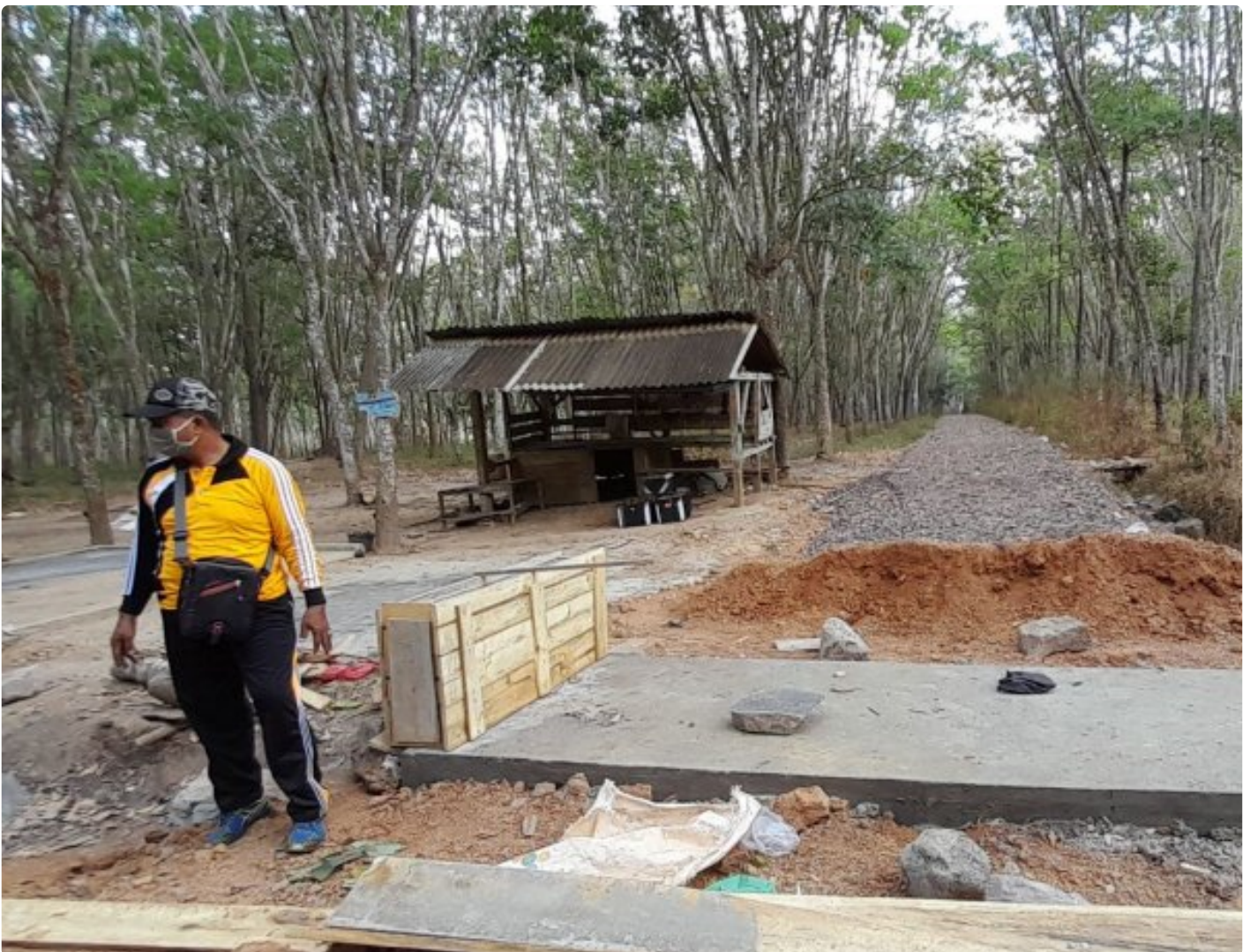
Kepala Desa Jaya Sakti Monitoring Pembangunan
